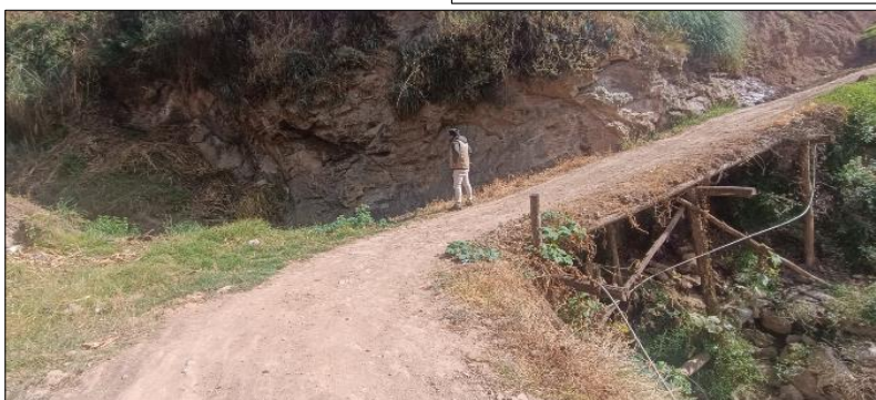
Tramo de la quebrada que cruza un camino de acceso rural con un puente rústico de madera sobre la quebrada, mostrando signos de deterioro y riesgo de colapso.
